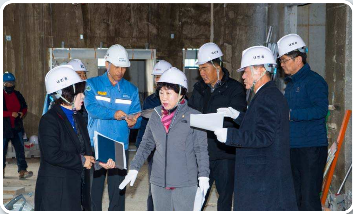
2019년도 행정사무감사 현지조사 (2019. 11. 26.) 고흥 치매안심 요양병원 확충 사업 현장 확인
